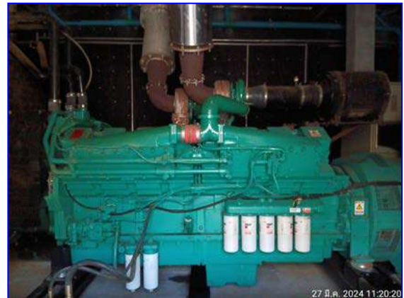
รูปที่ 2.21 เครื่องกำเนิดไฟฟ้าสำรอง และถังน้ำมันสำรอง
