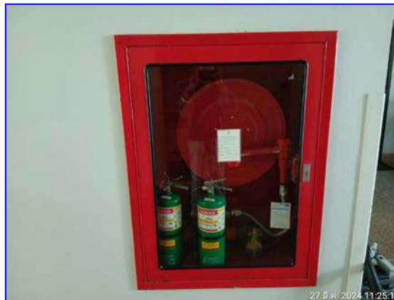
รูปที่ 2.40 ตู้เก็บสายฉีดน้ำดับเพลิง
